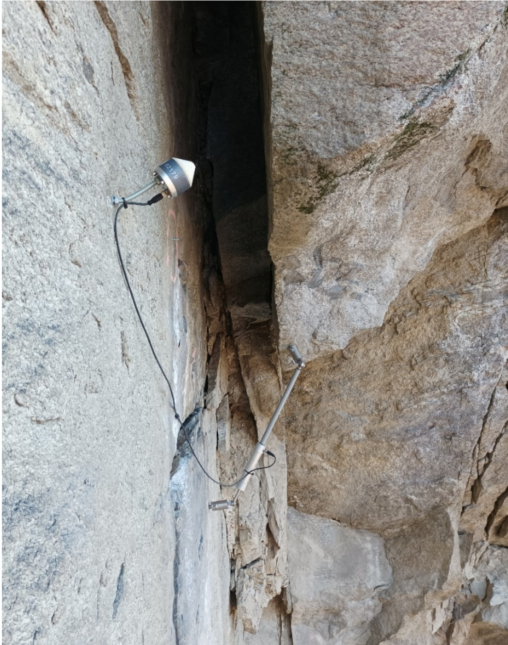
Bild 1: Typische Installation eines AarteLink® TJM ng.
